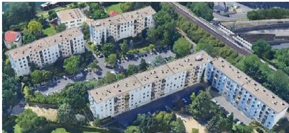
5. ETANCHEITE DE TOITURE + FACADE
