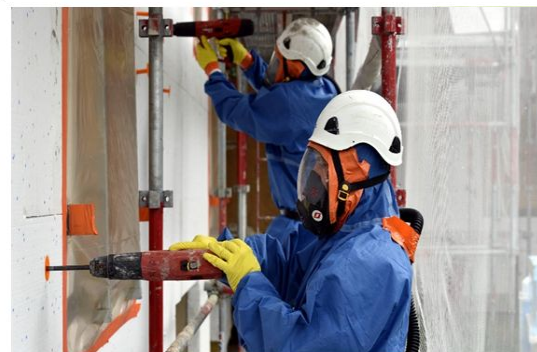
3. TRAITEMENT AMIANTE ET PLOMB
