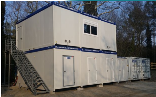
1. INSTALLATION DE CHANTIER
