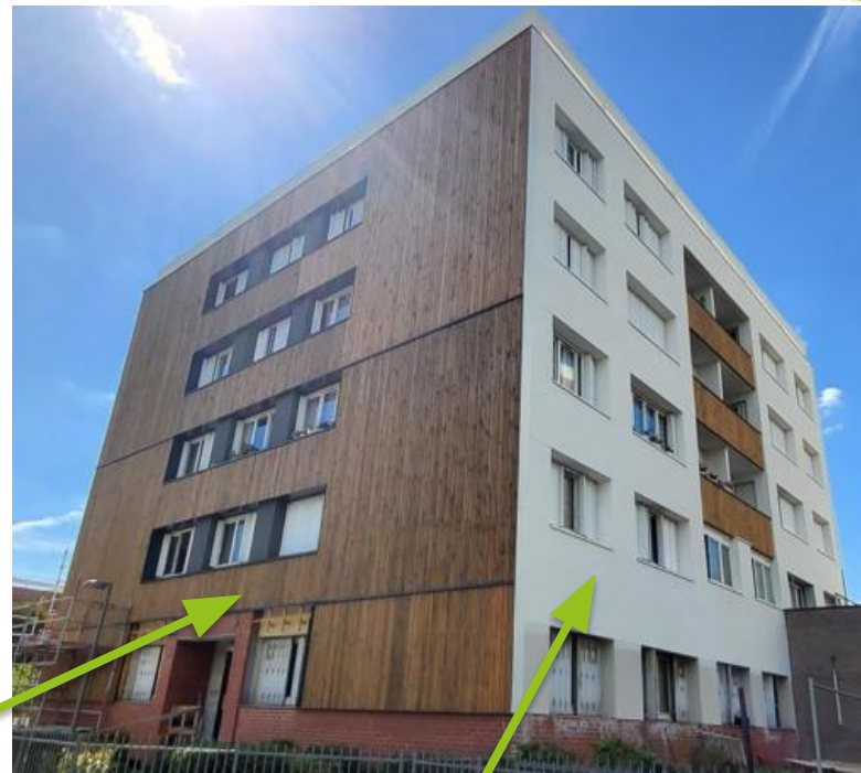
ENDUIT MINCE SUR ISOLANT
