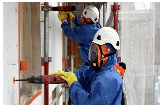
3. TRAITEMENT AMIANTE ET PLOMB
