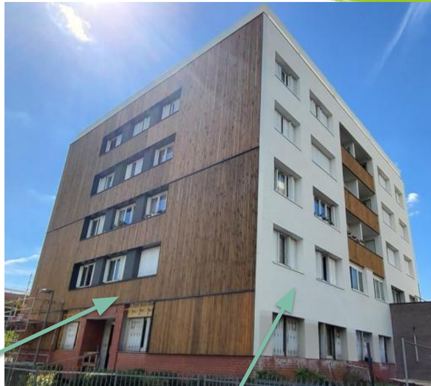
ENDUIT MINCE SUR ISOLANT
