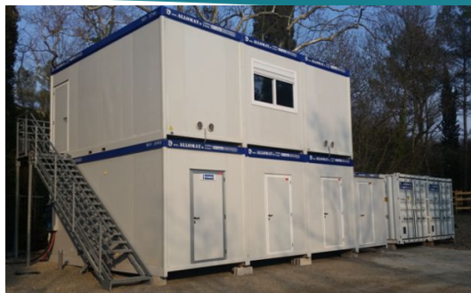
1. INSTALLATION DE CHANTIER
