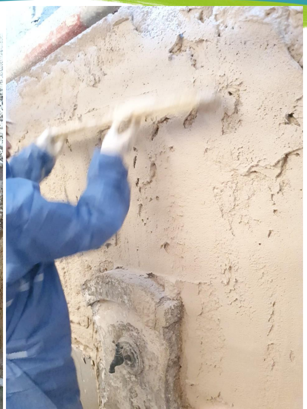
POSE ENDUIT AVEC BILLES AEROGEL INTEGRES
