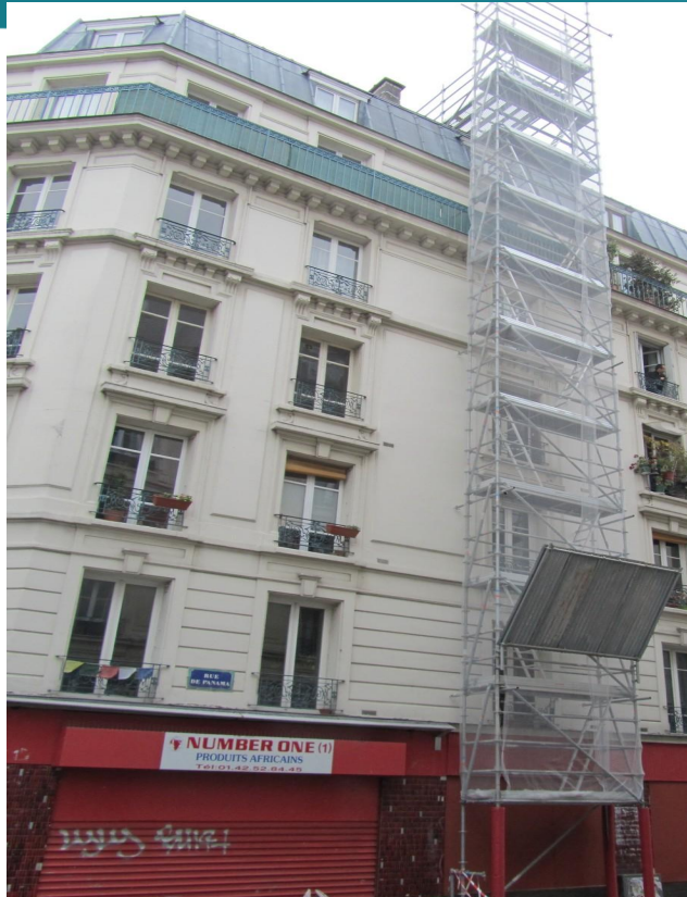
INSTALLATION SAPINE POUR ACCEDER A LA COUR INTERIEURE
