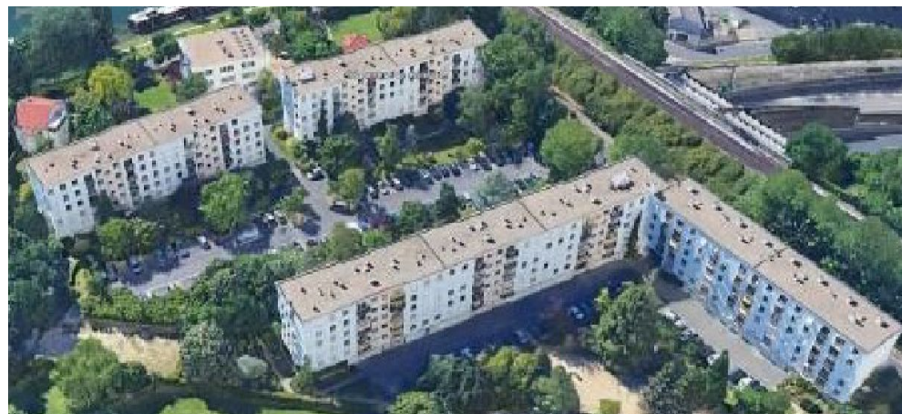
5. ETANCHEITE DE TOITURE + FACADE
